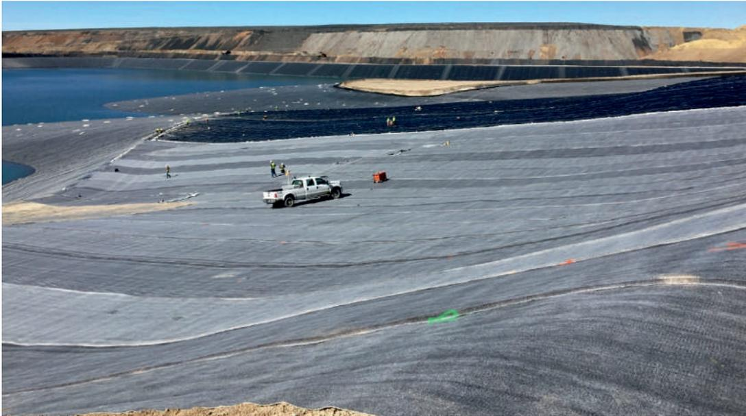
**Рисунок 4. Пример строительства хвостохранилища с противофильтрационным экраном<sup>7</sup>**
